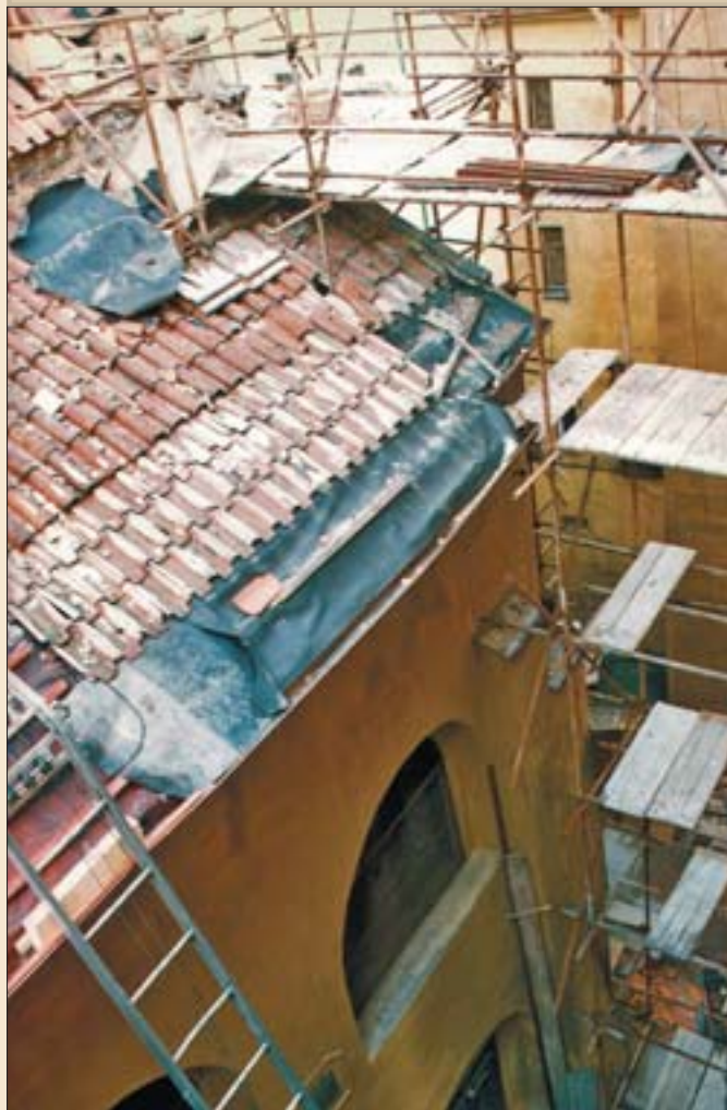
Oprava a rekonstrukce Maiselovy synagogy, která probíhala v letech 1994–1995, byla zahájena opravou střešní krytiny lodi budovy.
